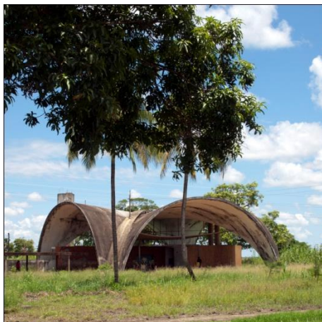
Fig. 11 - Monteiro & Giro – Messe da Fábrica de Cerâmica, Quelimane (foto Elisiário Miranda, 2009).
