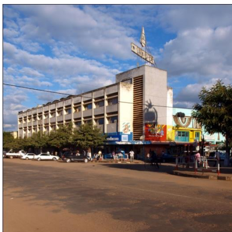
Fig. 5 - Prédio Montalto, Chimoio (foto Elisiário Miranda, 2010).
