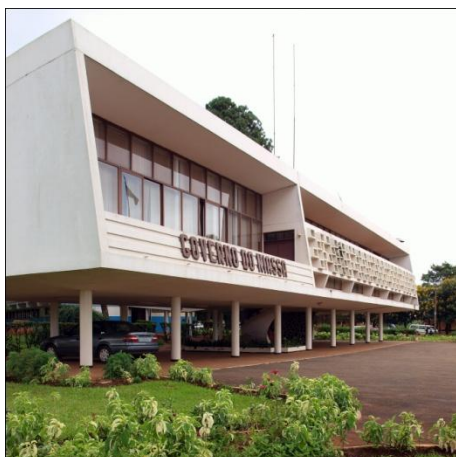
Fig. 7 - Palácio das Repartições, actual Governo do Niassa, Lichinga (foto Elisiário Miranda, 2009).
