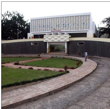
Fig. 9 - Bloco Operatório do Hospital Central de Nampula (foto Elisiário Miranda, 2010).
