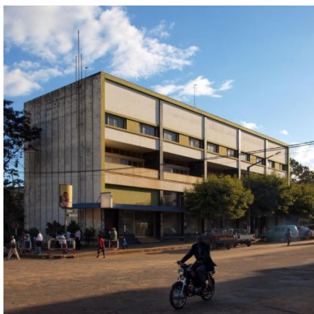
Fig. 4 - Antigo edifício da agência e habitações dos funcionários da Delegação do Banco Nacional Ultramarino, Chimoio (foto Elisiário Miranda, 2010).
